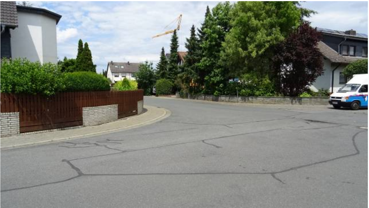
Einmündung in die Straße „Am Brückel“ (vorhandene Beschilderung)
